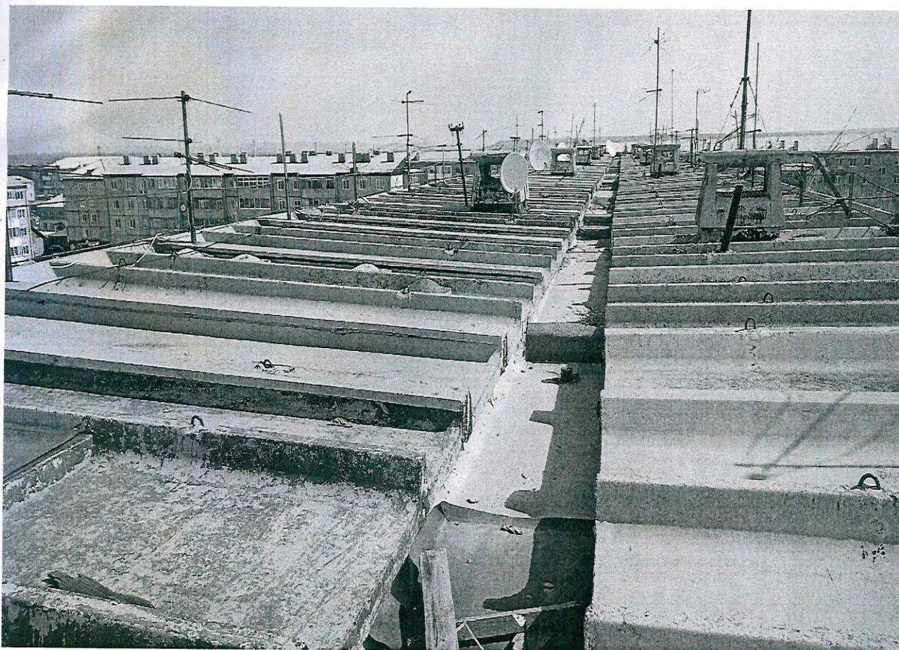
Фото №2 Общий вид лотковой кровли
